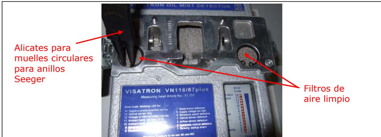
**Figura 46:** Cambio de los filtros del aire
